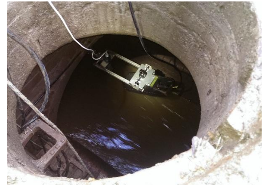
Abb. 1: Einbau in Sammler DN1400
